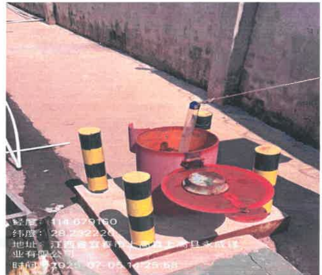
W2 初期雨水池旁地下水监测井
