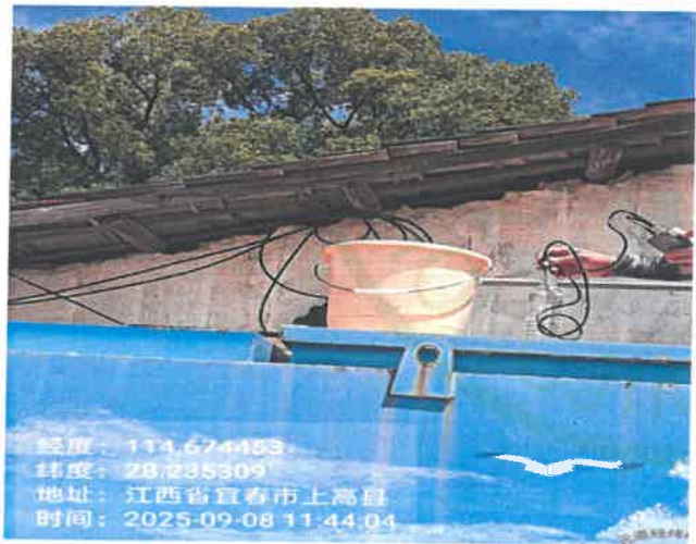
W1 生活污水排放口 DW003
